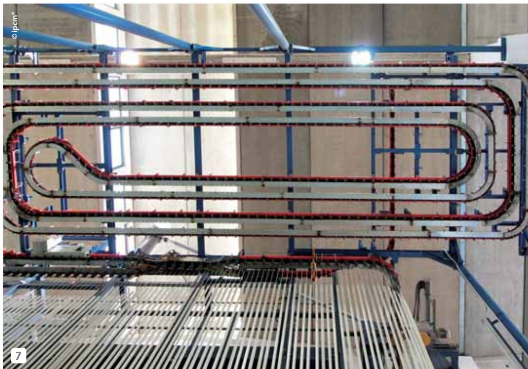
7 El pulmón de acumulación del circuito baipás.
