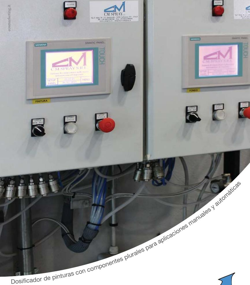
Dosificador de pinturas con componentes plurales para aplicaciones manuales y automáticas
