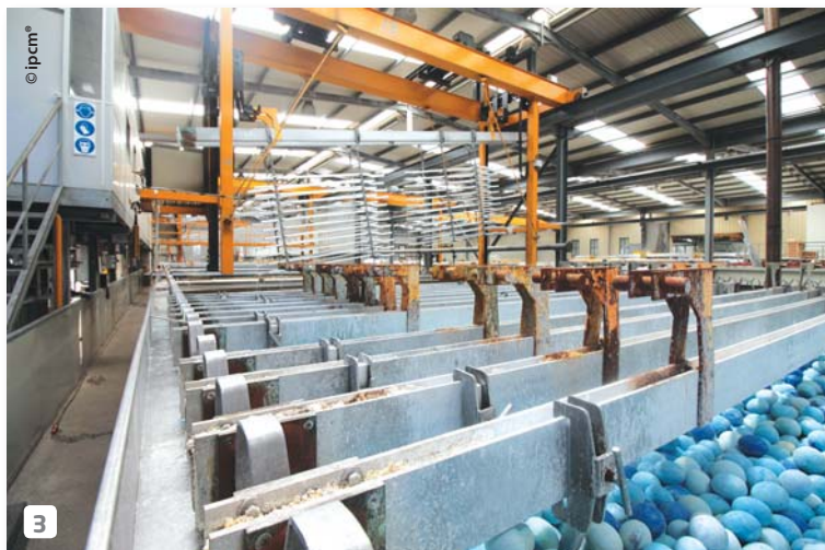
3 Línea de anodizado totalmente automatizada, con una potencia instalada de 36.000 amperios.
